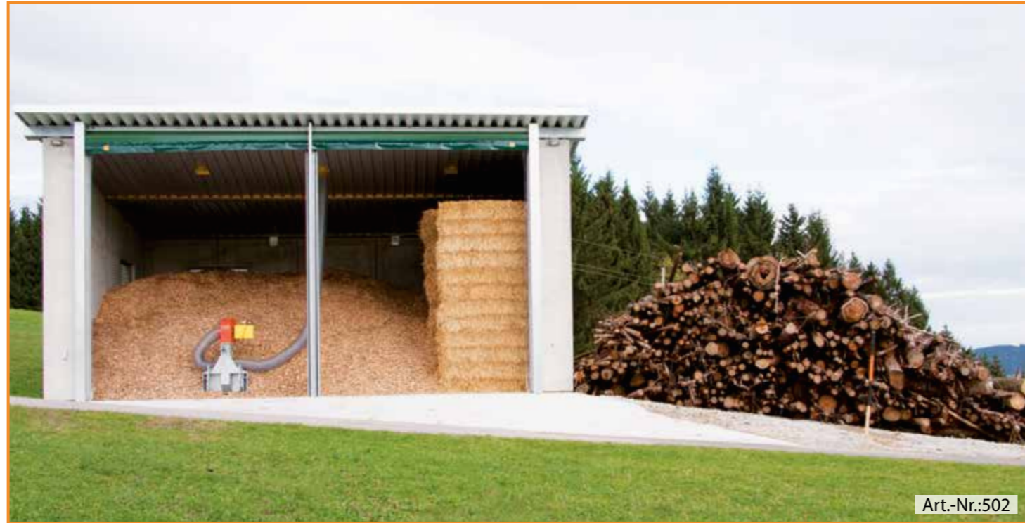
Hackgutlager mit integrierter Dachabsaugung
