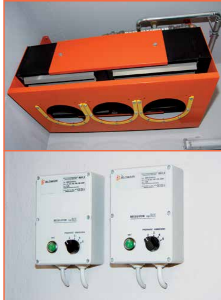
Kompakter Wärmetauscher zur Anwärmung der Ansaugluft
