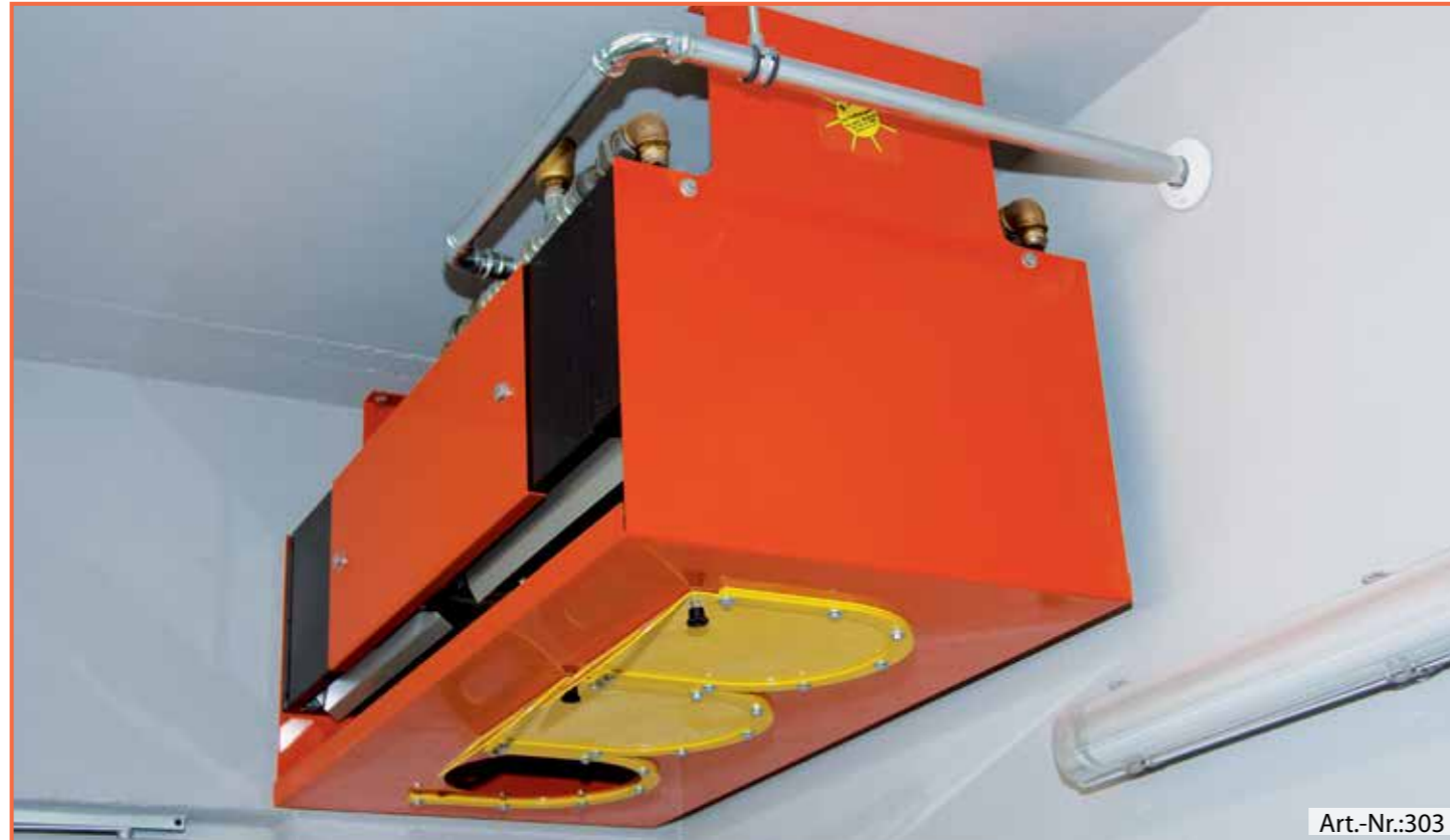
Kompakter Wärmetauscher zur Anwärmung der Ansaugluft
